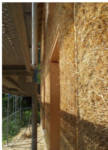
Abbildung 2: Strohwand im eingebauten Zustand
