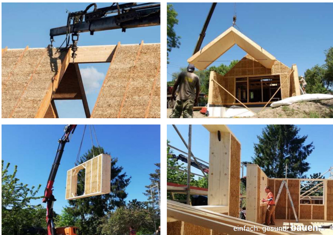
Abbildung 3: Montage der Lorenz Module aus Holz und Stroh
